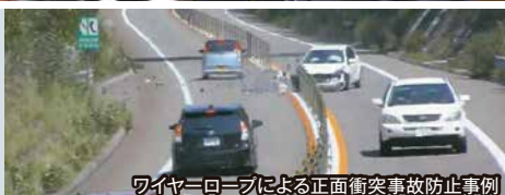
ワイヤーロープによる正面衝突事故防止事例
